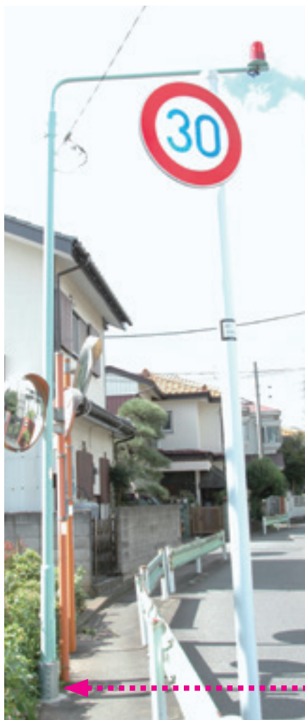
信号灯補修完了
