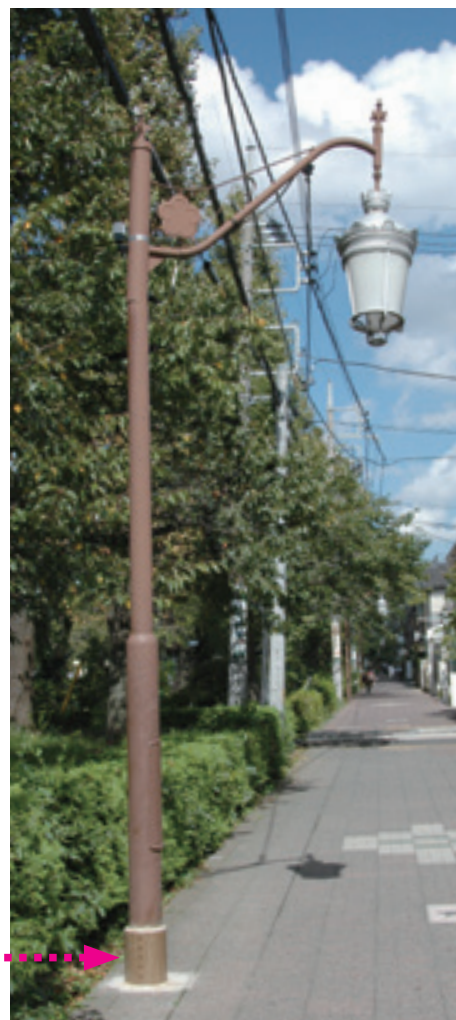
歩道灯補修完了
