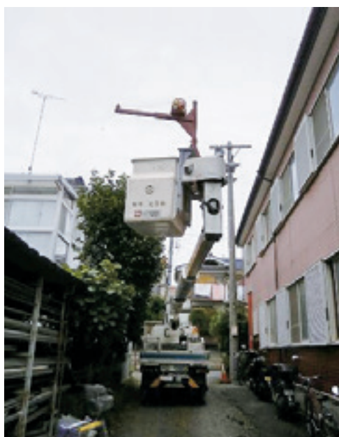
高所作業に取付作業中 ※車種により取付不可能な場合もあります
