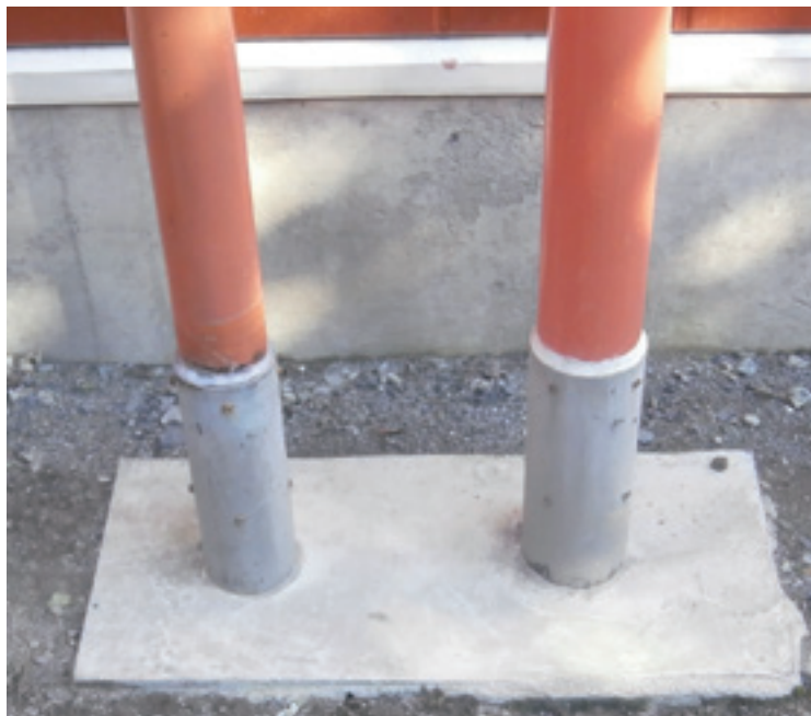
防錆カバー完成
