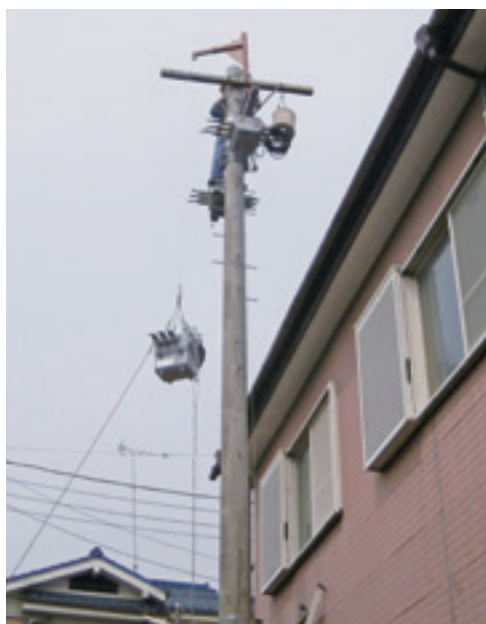
P.A.S取付・撤去工事中
