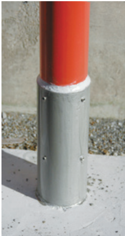
防水シリコン注入完成
