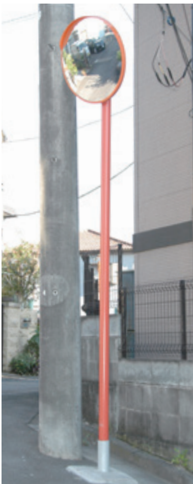
防錆カバー完成
