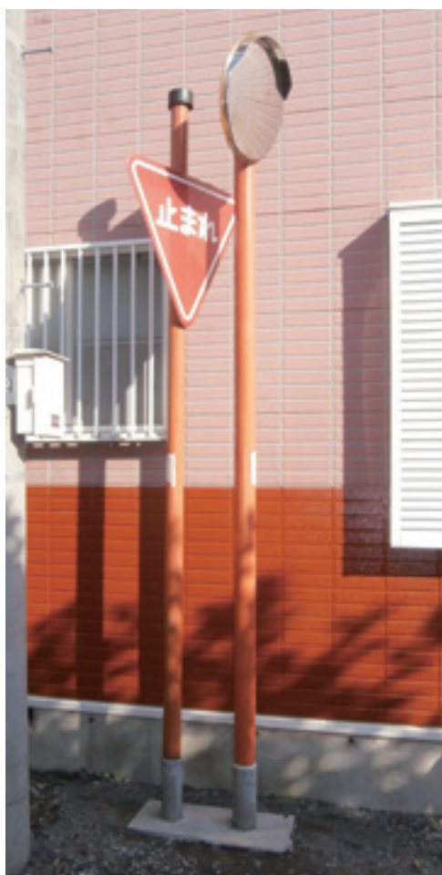
防錆カバー防水シリコン注入完成
