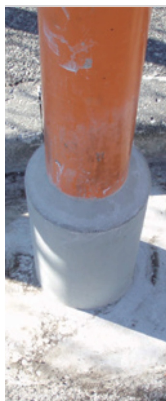
道路反射鏡補修
